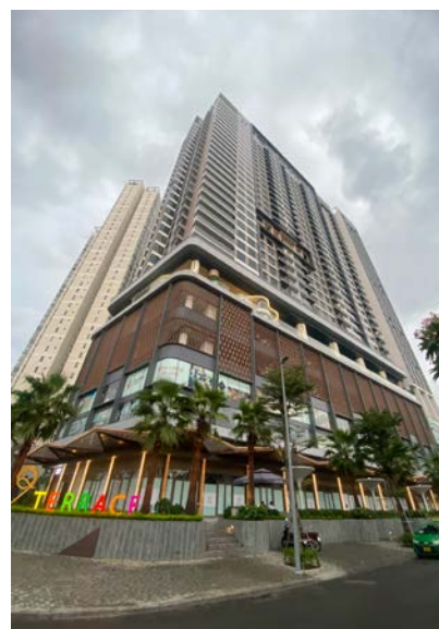
Dự án TTTM & Căn hộ Cao cấp Ghome Thảo Điền Quận 2
