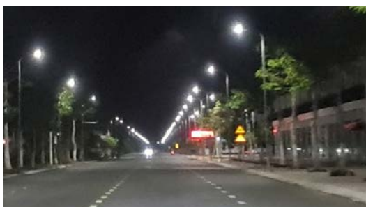
CSCC tuyến đường Võ Văn Tần, Tp. Vũng Tàu
