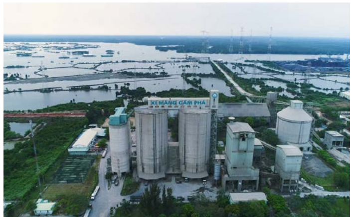
Nhà Máy Xi Măng Cẩm Phả
